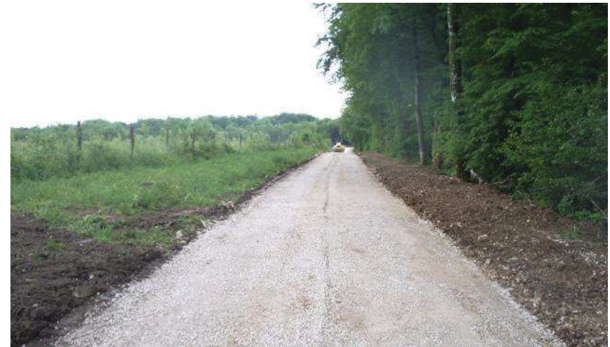
Photo 2: Exemple de piste de desserte aménagée (Source : EOLE-RES)
