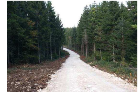
Exemple de piste après aménagement
