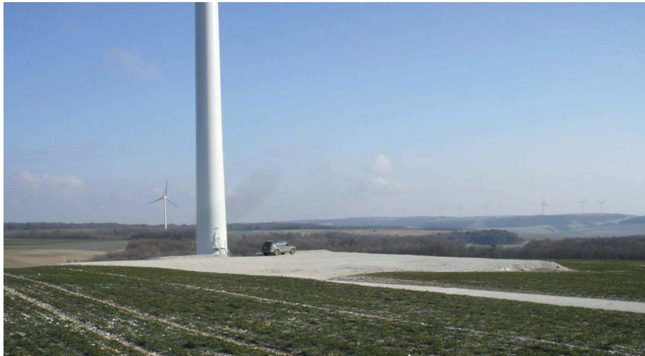
Photo 3 : Exemple d'aire de grutage (© EOLE-RES)
