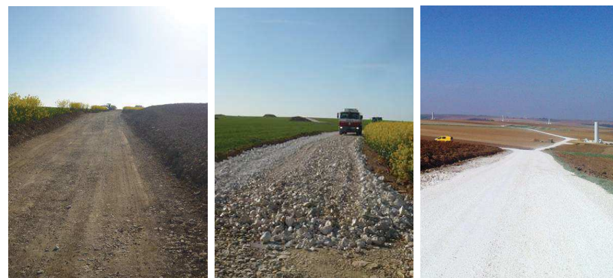
Photo 6 : De gauche à droite, opération de décapage ; mise en place de la couche de fond de forme ; mise en place de la couche de finition (Source : EOLE-RES)
